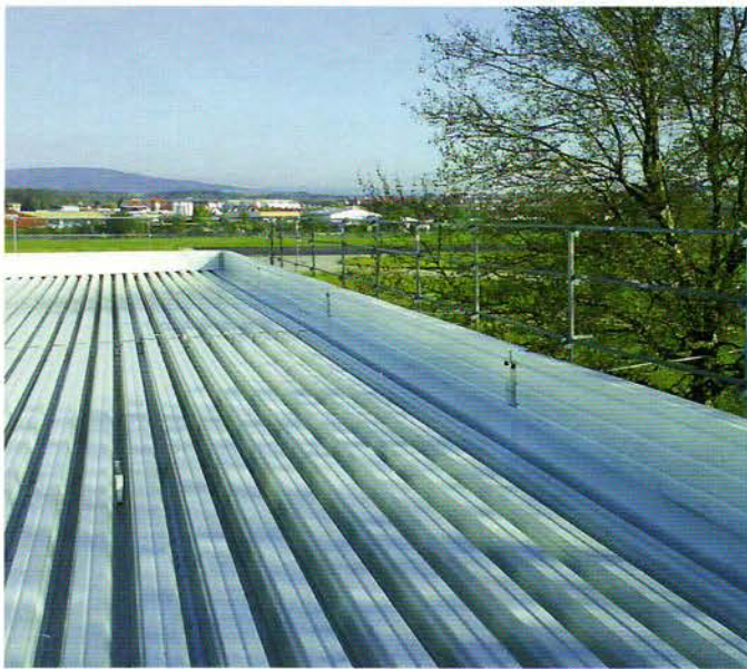
2300 Quadratmeter Trapezblechprofile mussten verlegt und abgedichtet werden.
