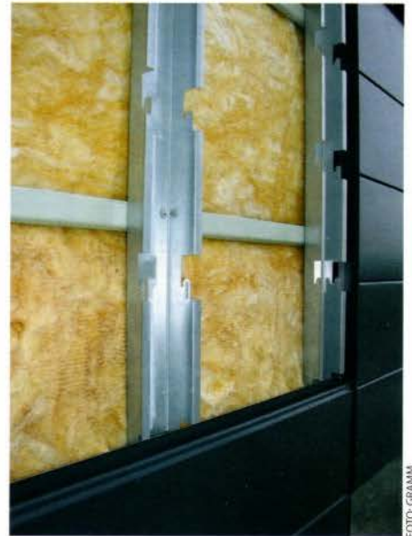
Die Halteprofile sind mit Ausschnitten entsprechend der Profilform des Sidings versehen. Dieses System ermöglicht eine maßgenaue Montage der horizontal verlegten Fassadenprofile.
