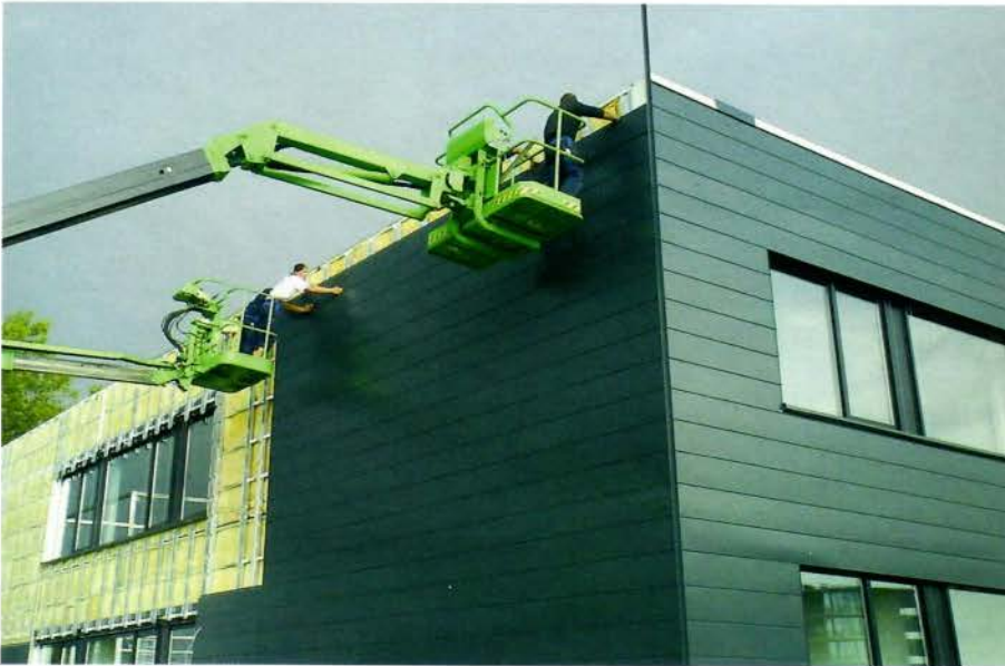
Die 7,5 Meter langen Sidings wurden in den letzten Höhenmetern von zwei Hubsteigern aus montiert.
