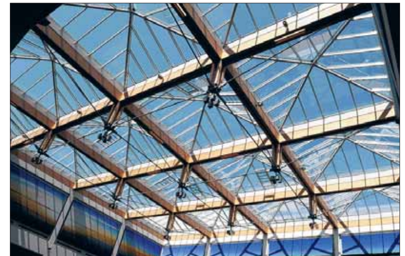
Interessante Dachkonstruktion: das neue Foyer Ost.
